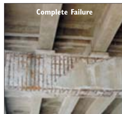
Spalling
